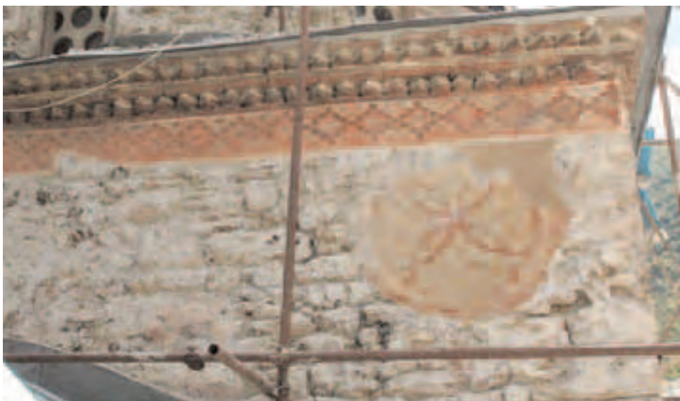
Сл. 52 - Северни изглед постоља куполе цркве Св. Апостола после уклањања продужног и потклобученог малтера
