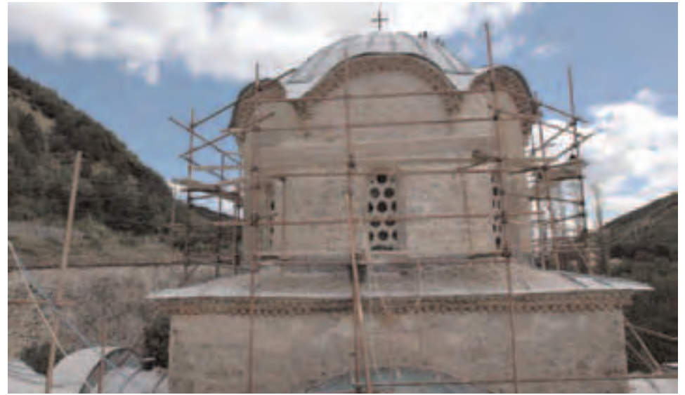
Сл. 49 - Изглед куполе и кубичног постоља цркве Св. Апостола са западне стране, пре уклањања поломби и дерсовања од продужног малтера
