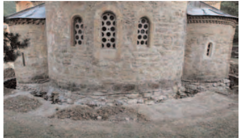
Сл. 44 - Изглед источне стране цркве Св. Апостола по чишћењу темељне зоне - жљоб у фасади је уклесан током радова 1962. године
