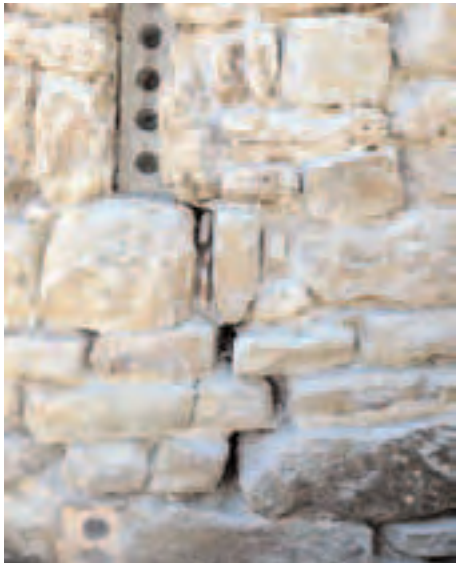
Сл. 46-47 - Јужна и северна апсида цркве Св. Апостола са несанираним пукотинама испод широких спојница од продужног малтера
