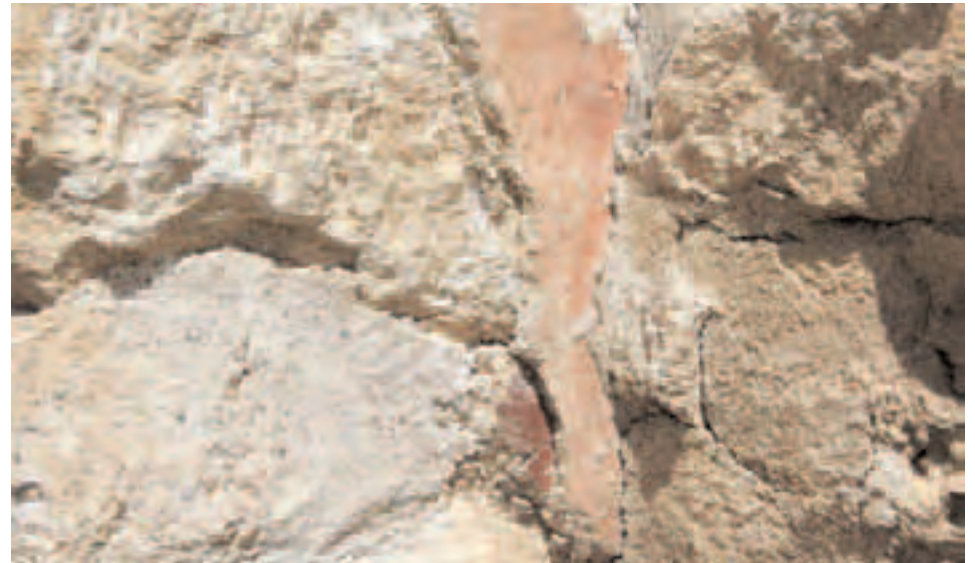
Сл. 57 - Деталј јужне фасаде цркве Св. Апостола са фрагментима првобитног фасадног малтера из 13. века и малтера из обнове у 14. веку
