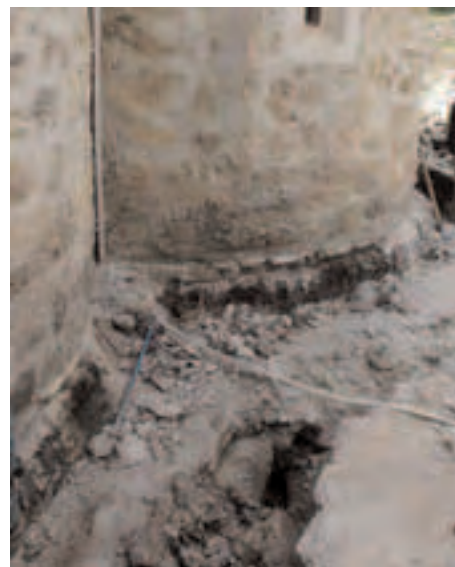
Сл. 38-39 - Изглед северног зида цркве Св. Апостола; испод горњег бетонског канала и бетонске испуне био је незатрпан канал - реципијент воде са затвореним одводима ка бившим бунарима
