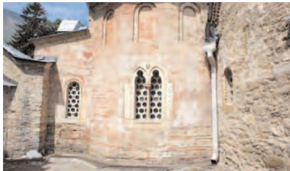
Сл. 65 - Изглед апсиде Богородичине цркве са остацима оштећеног и потклубученог бојеног малтера
