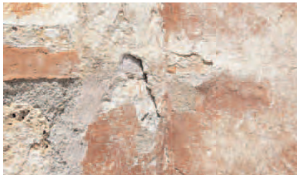
Сл. 66 - Детаљ оштећеног и потклубученог првобитног фасадног малтера са апсиде Богородичине цркве
