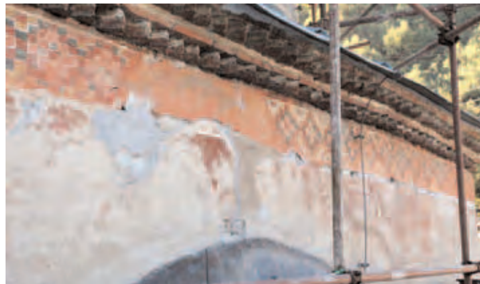
Сл. 53 - Источни изглед постоља куполе цркве Св. Апостола са очуваним деловима фриза испод венца и пломбама од продужног малтера
