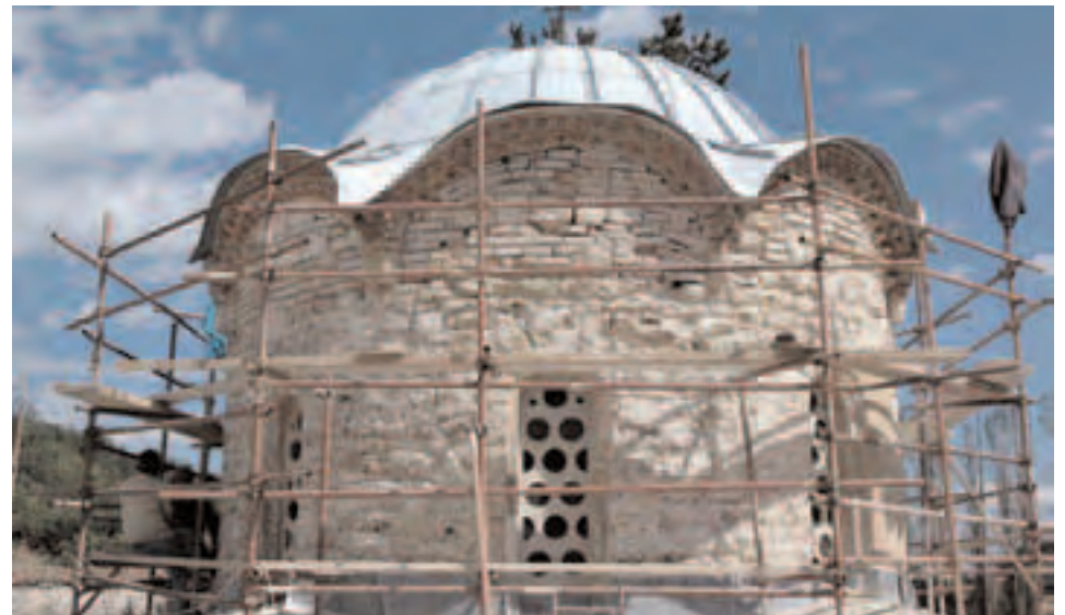
Сл. 50 - Изглед тамбура цркве Св. Апостола са западне стране, после уклањања пломби и дерсовања из 1932. године
