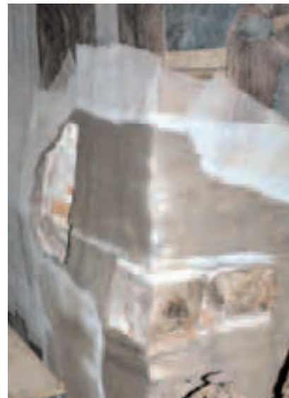
Сл. 78-79 - Изглед и детаљ здраве дрвене греде пробушене кроз средиште у дужини од три метра из непознатих конзерваторских разлога
