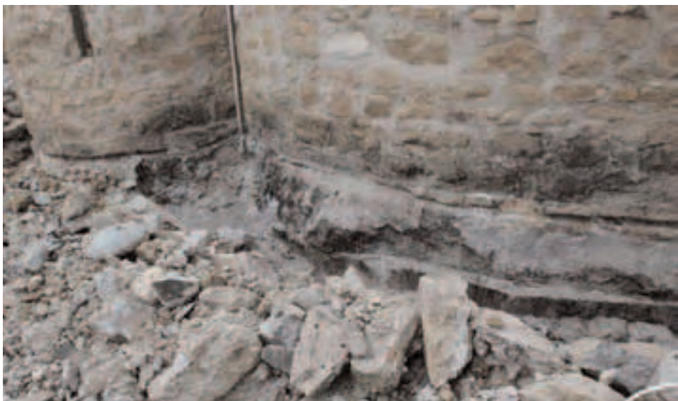
Сл. 37 - Источна страна цркве Св. Апостола по уклањању тротоара и отвореног бетонског канала, изглед темеља обложених бетоном и битуменом
