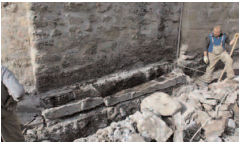
Сл. 36 - Изглед северног зида цркве Св. Апостола током уклањања горњег канала и бетона којим је испуњен простор између горњег и доњег канала
