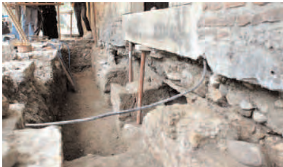
Сл. 64 - Изглед остатака зидова старије грађевине на које су се ослањали, преко дрвених греда, темељи јужног зида Богородичине цркве; греде су иструлиле и нестале, а лежишта су била испуњена земљом
