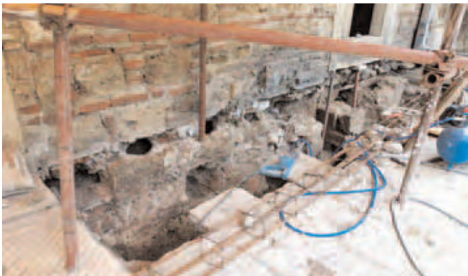
Сл. 63 - Изглед темеља јужног зида Богородичине цркве након уклањања шута и глине док је земља испуњавала лежишта иструлелих дрвених греда
