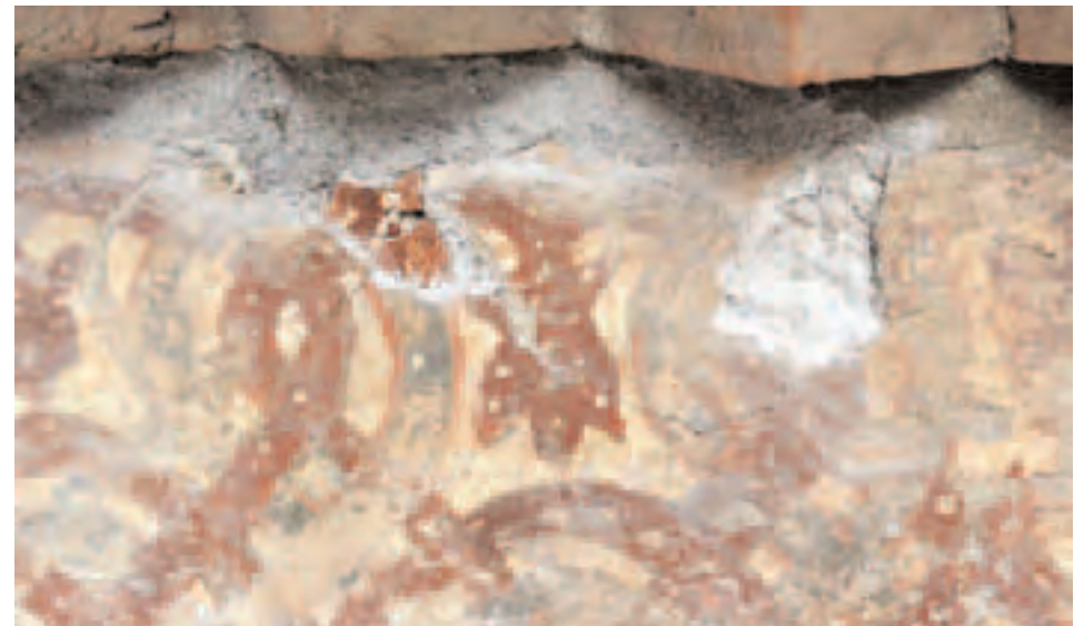
Сл. 58 - Деталј очуваног сликаног фриза испод венца апсиде цркве Св. Апостола, испод њега фрагмент првобитног фасадног малтера
