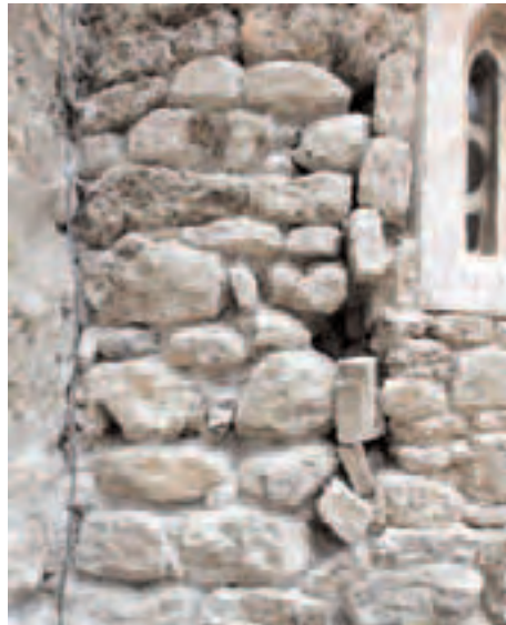
Сл. 46-47 - Јужна и северна апсида цркве Св. Апостола са несанираним пукотинама испод широких спојница од продужног малтера
