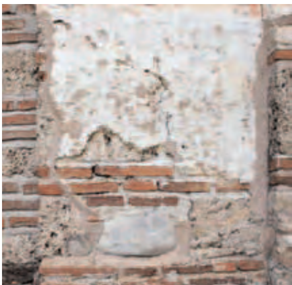
Сл. 27-28 - Детал фреско-композиција са западне и јужне фасаде припрате и отпадање комада фреско-малтера и поред опшивања продужним малтером
