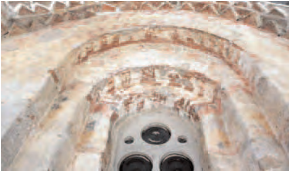
Сл. 75 - Изглед прозора на тамбуру Богородичине цркве са остацима сликаног украса опшивеног продужним малтером
