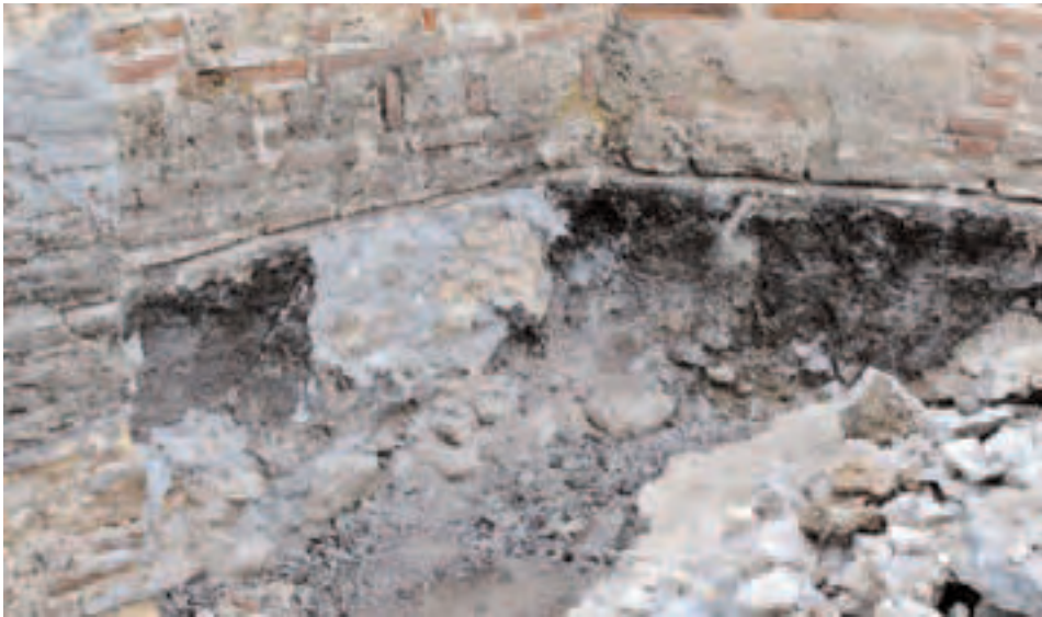
Сл. 59 - Изглед темеља Богородичине цркве са источне стране по уклањању отвореног бетонског канала
