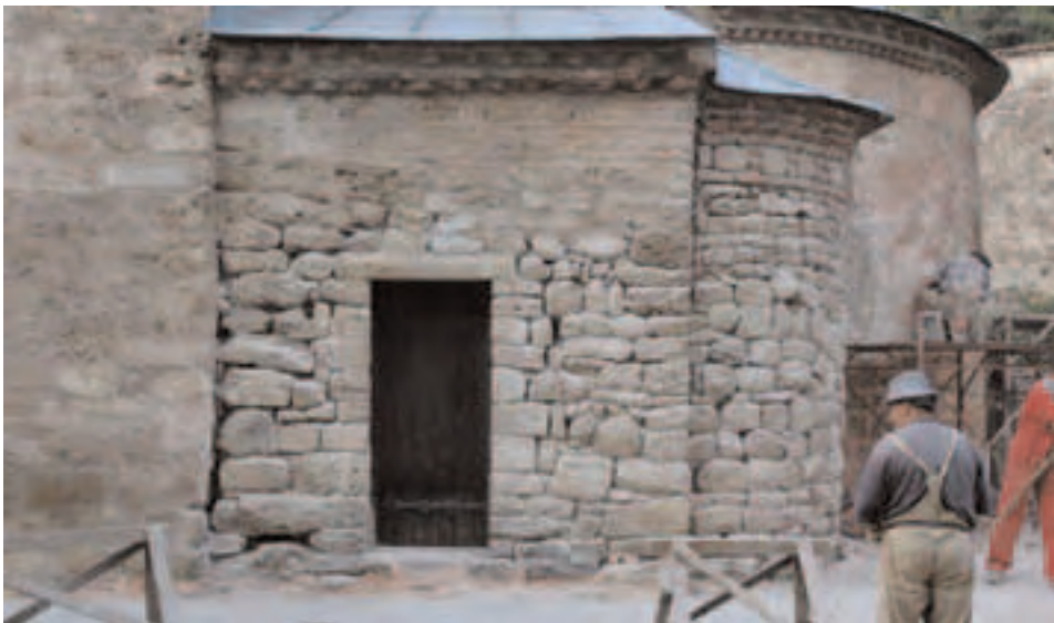
Сл. 48 - Изглед ђаконикона цркве Св. Апостола после уклањања спојница од продужног малтера
