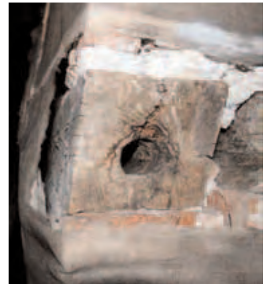
Сл. 78-79 - Изглед и детаљ здраве дрвене греде пробушене кроз средиште у дужини од три метра из непознатих конзерваторских разлога
