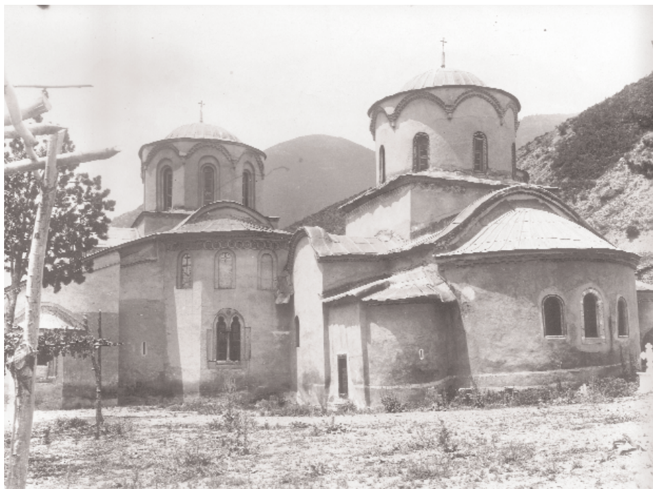
Сл. 1 - Изглед црква Пећке патријаршије, пре последњег бојења фасада изведеног око 1925. године
