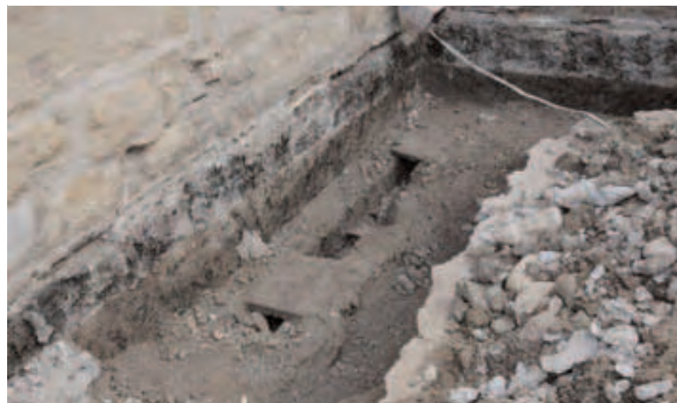
Сл. 40 - Доњи бетонски канал уз северни зид цркве Св. Апостола садржавао је заробљену воду, која је константно влажила темеље цркве
