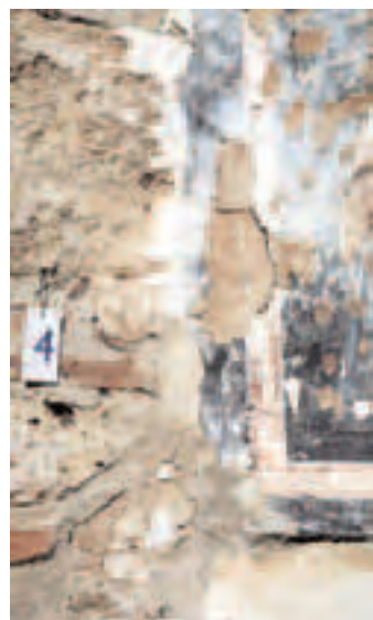
Сл. 27-28 - Детал фреско-композиција са западне и јужне фасаде припрате и отпадање комада фреско-малтера и поред опшивања продужним малтером
