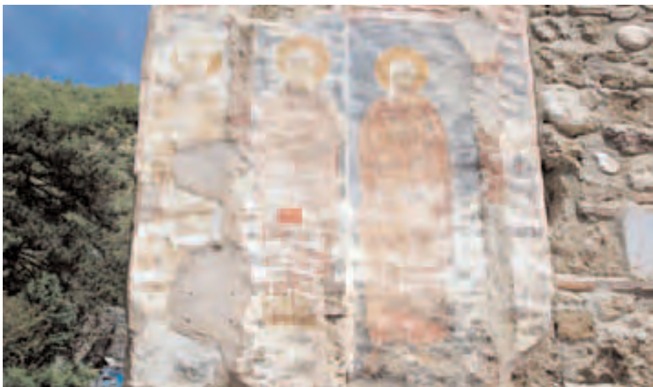
Сл. 26 - Фреско-композиција на југозападном углу припрате, опшивена и плумбирана малтером који садржи цемент
