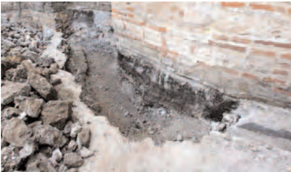
Сл. 60 - Темељи апсиде Богородичине цркве обложени бетоном и битуменом у радовима 1962. године
