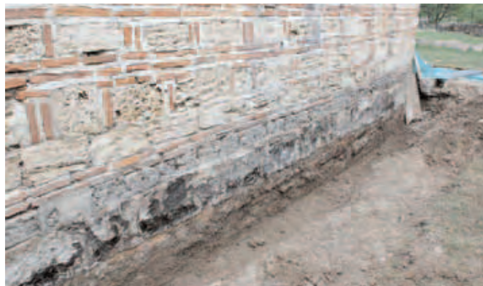
Сл. 133 - Изглед темељне зоне јужног цркве Св. Николе, после уклањања отвореног бетонског канала и подлоге од облутака - темељ у висини канала је био са цементном облогом и битуменом
