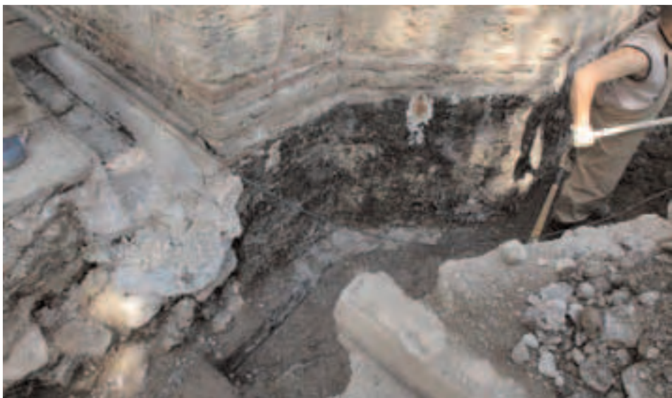
Сл. 131 - Изглед југоисточног угла цркве Св. Николе - са јужне стране је горњи канал лежао на слоју од крупних облутака, који је као дренажа прикупљао воду из околног терена и доводио је до темеља цркве
