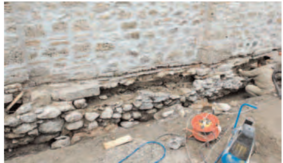
Сл. 119 - Изглед темеља западног зида припрате, после чишћења темеља од бетонске облоге; жлеб у дну зида је уклесан 1962. године приликом израде бетонске облоге темеља
