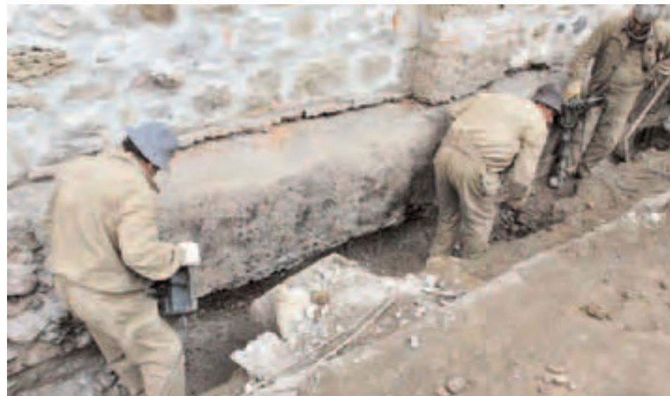
Сл. 107 - Изглед темеља северног дела западног зида приправе са бетонском облогом темеља, која је премазана битуменом
