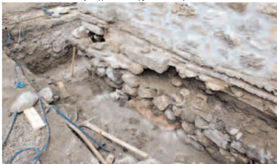
Сл. 115 - Изглед темеља припрате на северозападном углу после чишћења од бетонске облоге темеља; зид је изгубио ослонац у зони лица и био је ослоњен само на испуну (трпанац); у шупљини се види отисак дрвене греде
