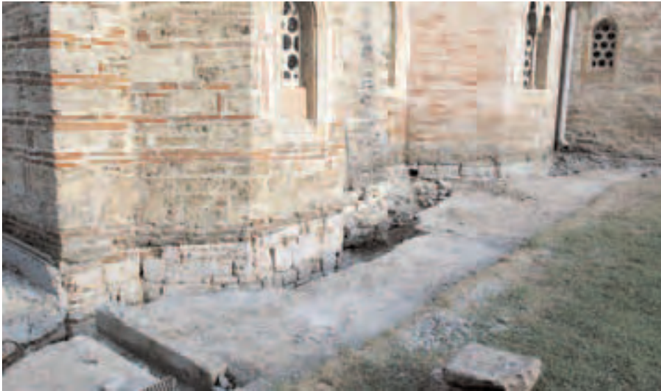
Сл. 134 - Изглед источне стране цркве Св. Николе, после уклањања бетонских канала и цементне облоге темеља
