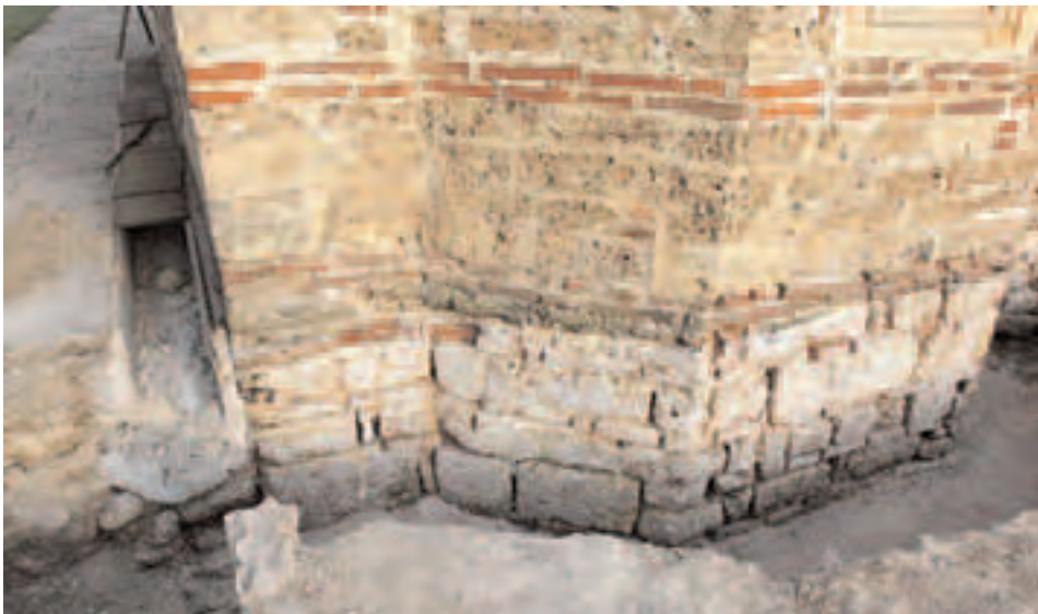
Сл. 135 - Изглед темељне зоне апсиде цркве Св. Николе, после уклањања бетонских канала и цементне облоге темеља
