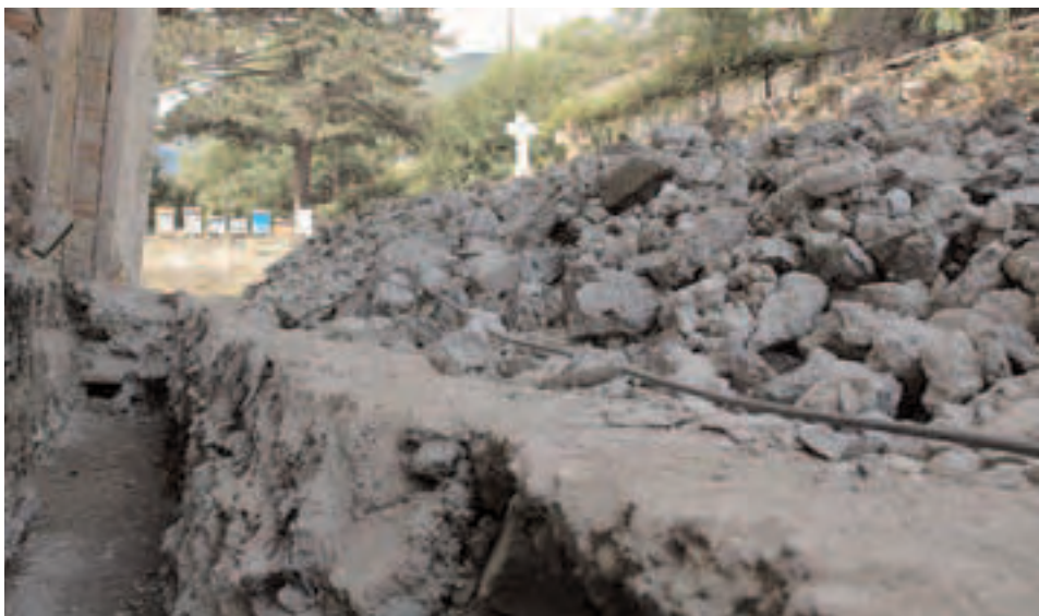
Сл. 85 - Изглед рова прокопаног кроз два канала и бетонску испуну између њих на северној страни цркве Св. Димитрија
