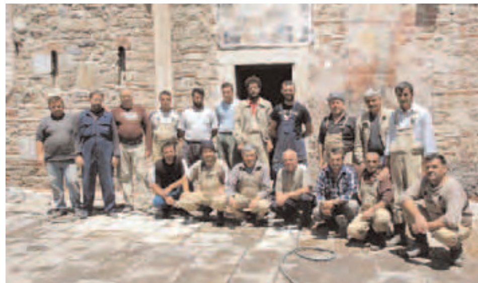
Сл. 144 - Радници који су изнели терет уклањања 400 тона бетона из темељне зоне цркава и шестомесечног боравка у манастиру ограђеном бодљикавом жицом
