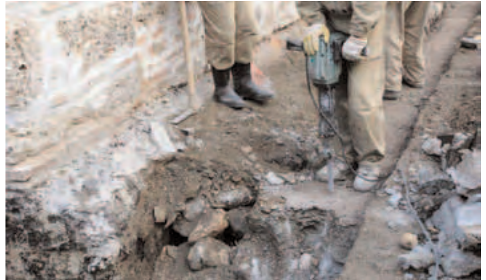
Сл. 101 - Изглед северозападног угла припрате - током радова 1983. године ископ је испуњен бетоном читавом дужином, а канали са испуном од крупног облутка су задржани, што је доводило воду до темељне зоне
