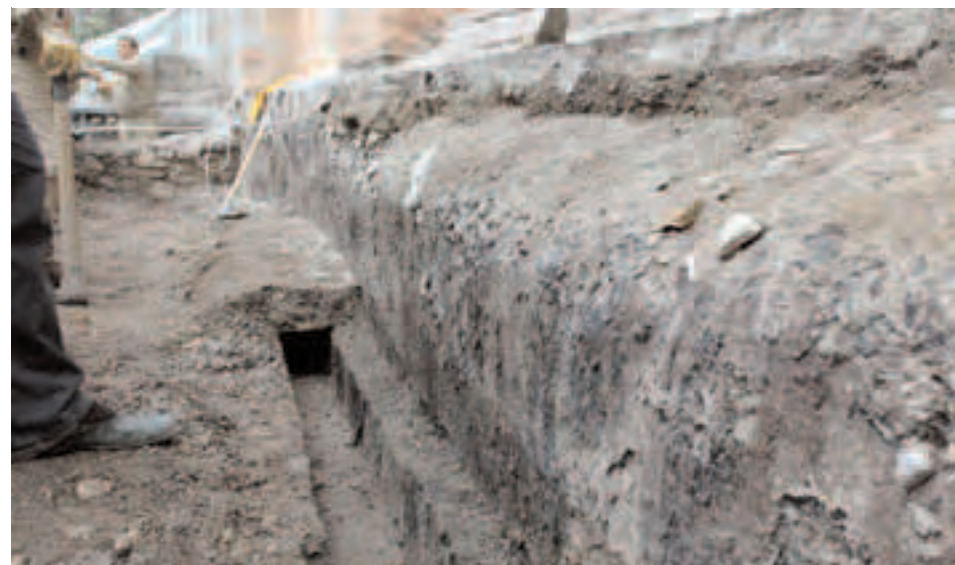
Сл. 111 - Изглед темеља западног зида припрате са доњим бетонским каналом и бетонском и битуменском облогом темеља
