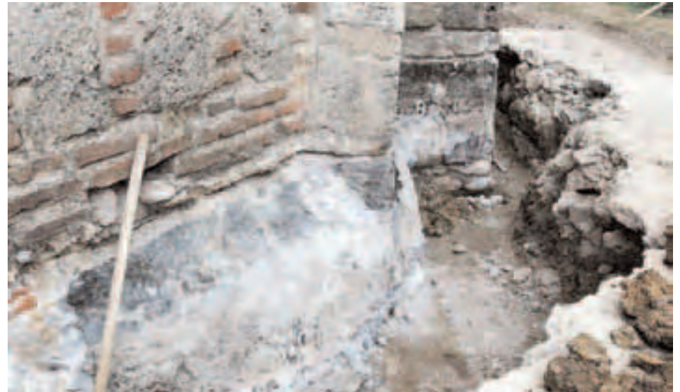
Сл. 83 - Изглед бетонске облоге темеља североисточног угла апсиде цркве Св. Димитрија
