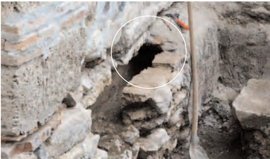
Сл. 117 - Детаљ темеља северног дела западног зида припрате; подметањем комада опеке је премошћена шупљина како би се извела цементна и битуменска облога темеља припрате
