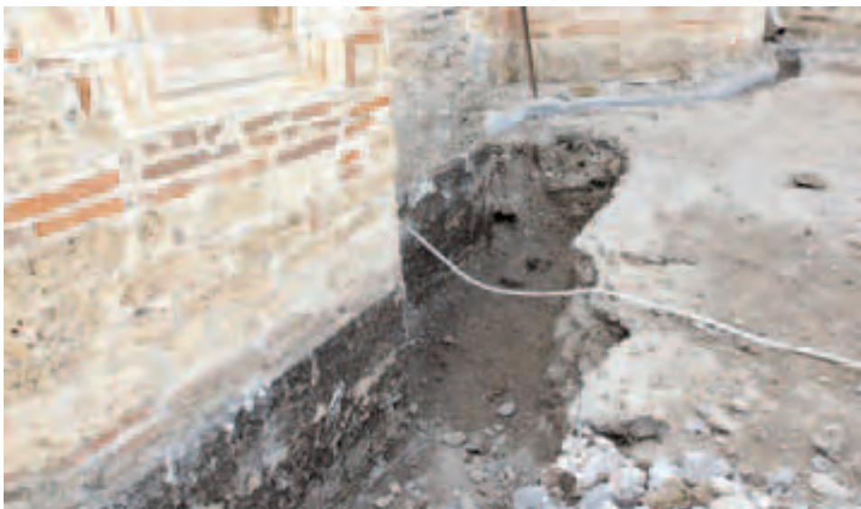
Сл. 132 - Изглед темељне зоне апсиде цркве Св. Николе, после уклањања бетонских канала и ливеног и ломљеног бетона - темељи су били обложени цементним малтером и премазани битуменом
