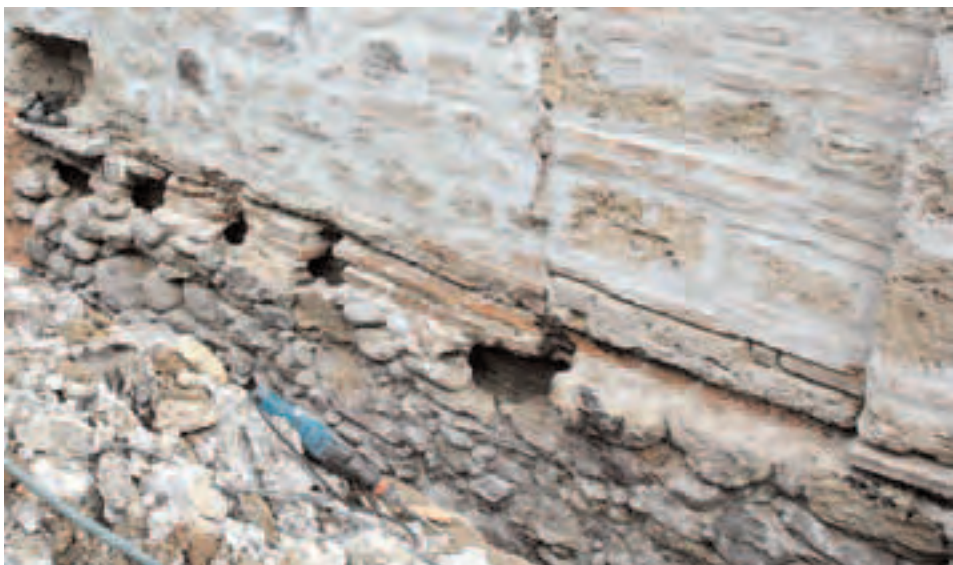
Сл. 104 - Изглед темеља приправе са северне стране после чишћења од бетонске облоге: показало да је преко темеља била постављена дрвена греда, сантрач, ради расподеле притисака од стубаца и стубова приправе
