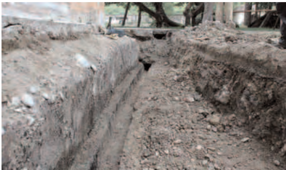
Сл. 112 - Изглед темеља јужног дела западног зида припрате са доњим каналом и бетонском облогом; ров на слици је у пуној ширини прокопан кроз масу бетона који је био подлога горњег, отвореног канала
