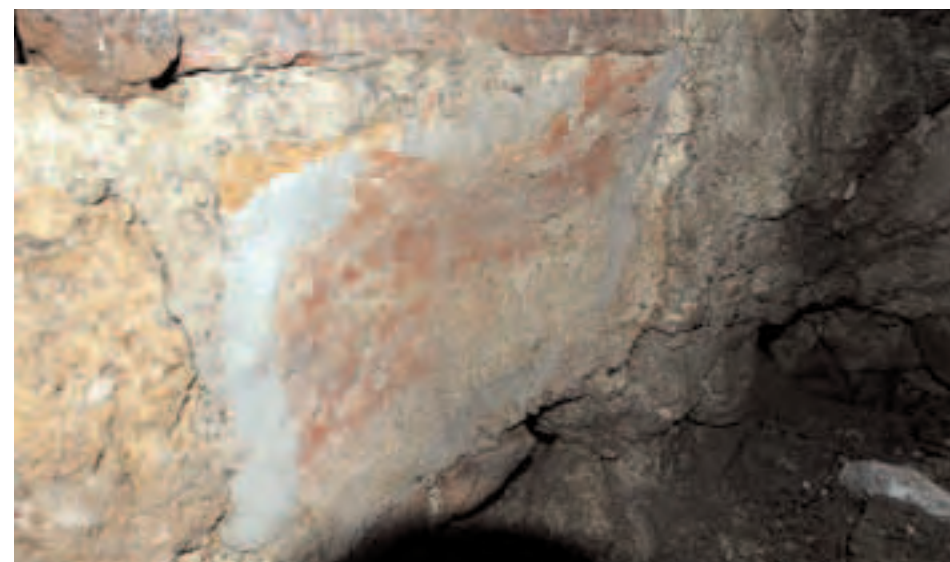
Сл. 143 - Детаљ црвеног малтера на зиду старије грађевине, испод јужног зида Богородичине цркве
