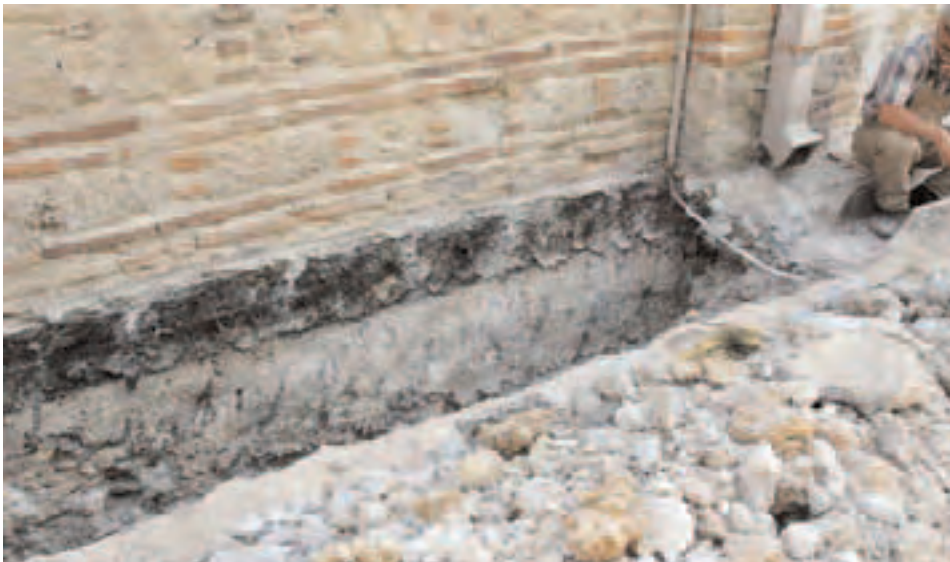
Сл. 82 - Изглед темеља северног зида цркве Св. Димитрија обложеног бетоном који је премазан битуменом
