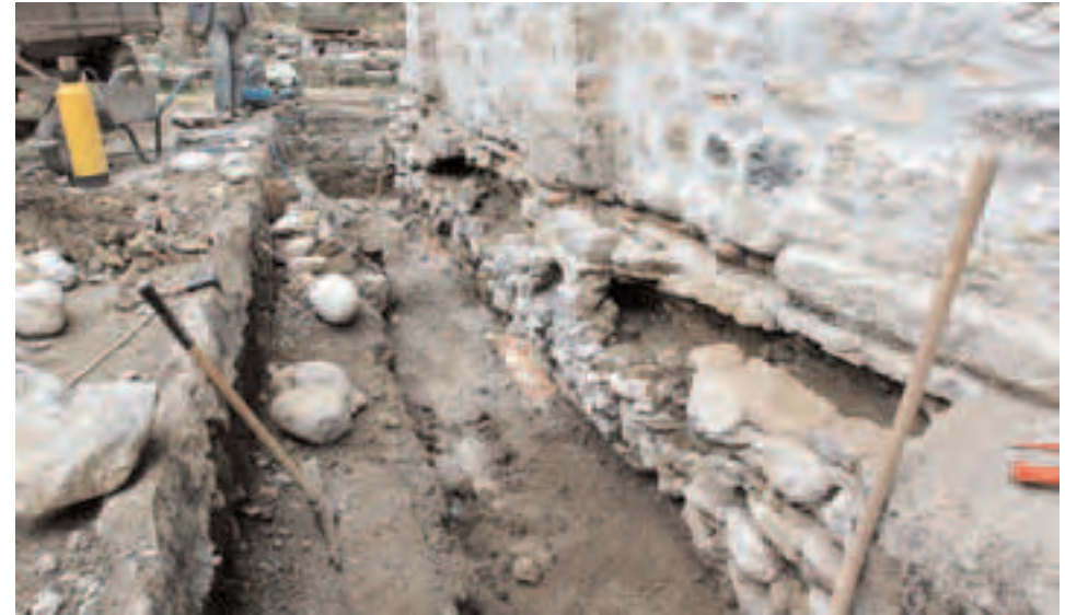
Сл. 118 - Изглед темеља северног дела западног зида припрате после чишћења темеља од бетонске облоге; рупа пуна земље и покривена цементном и битуменском облогом пружала се по целом обиму припрате
