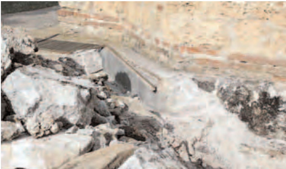
Сл. 129 - Изглед отвореног бетонског канала са источне стране цркве Св. Николе, на почетку демонтаже
