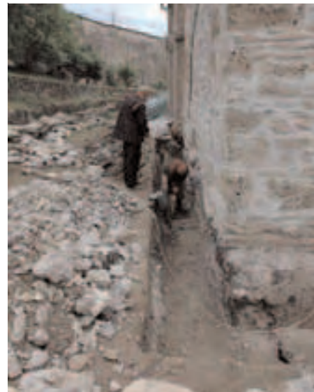
Сл. 102 - Изглед северозападног угла припрате - темељи обложени бетоном и премазани битуменом
