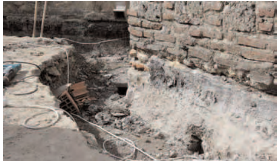
Сл. 84 - Изглед бетонске облоге темеља апсиде цркве Св. Димитрија
