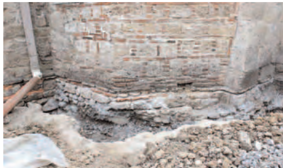
Сл. 88 - Изглед темеља апсиде цркве Св. Димитрија очишћеног од бетона и битумена: угао темеља је просечен ради спровођења канала из 1962. године
