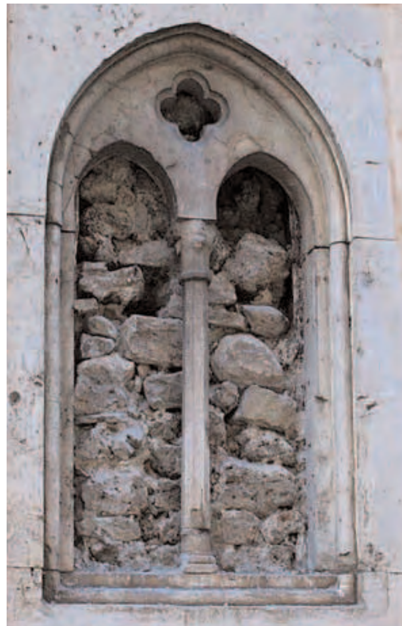
Сл. 95 - Изглед прозора - бифоре и грубе испуне на северној фасади цркве Св. Димитрија
